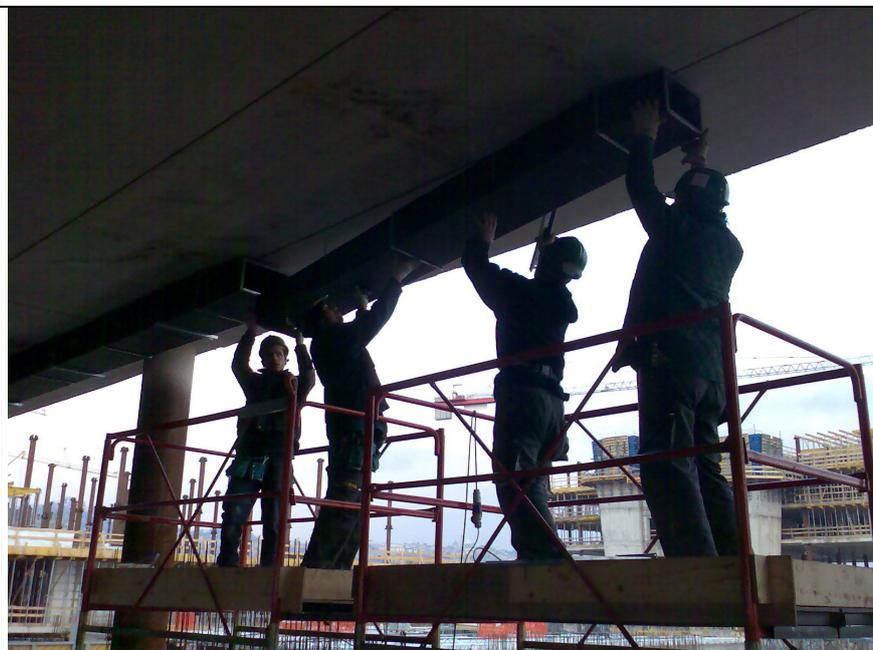
Posizionato il canale si procede al suo fissaggio, prima con l'ancoraggio delle staffe di sostegno e poi con il serraggio dei bulloni di condotta
