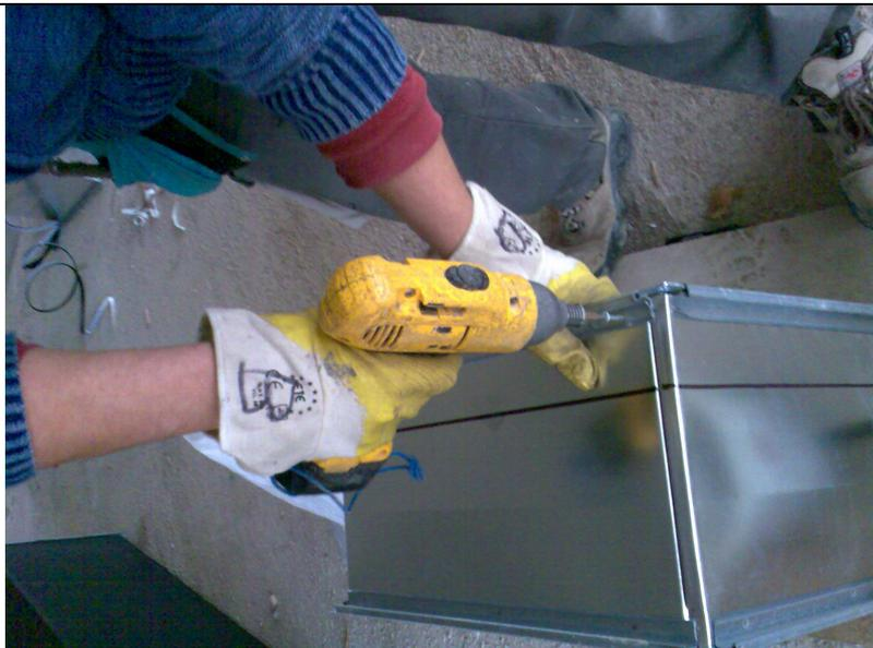
Le viti vengono serrate manualmente o con l'impiego di un piccolo avvitatore a batteria
