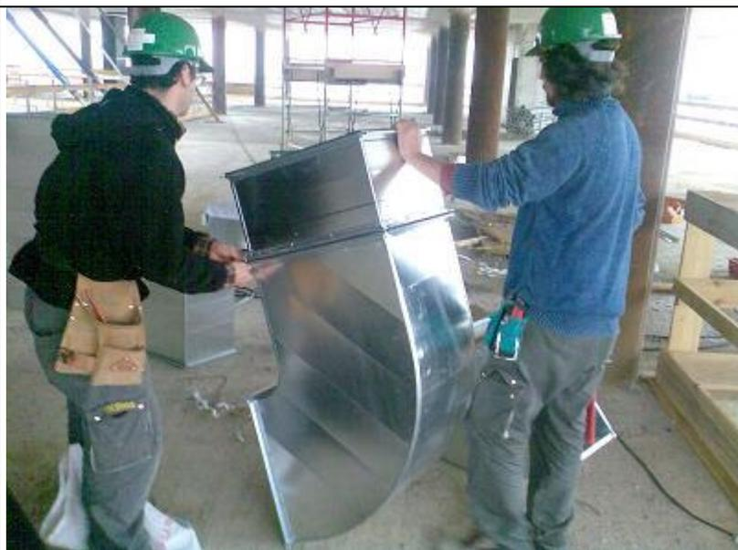
Una volta pressamblato il canale viene movimentato da due operatore e posizionato in opera
