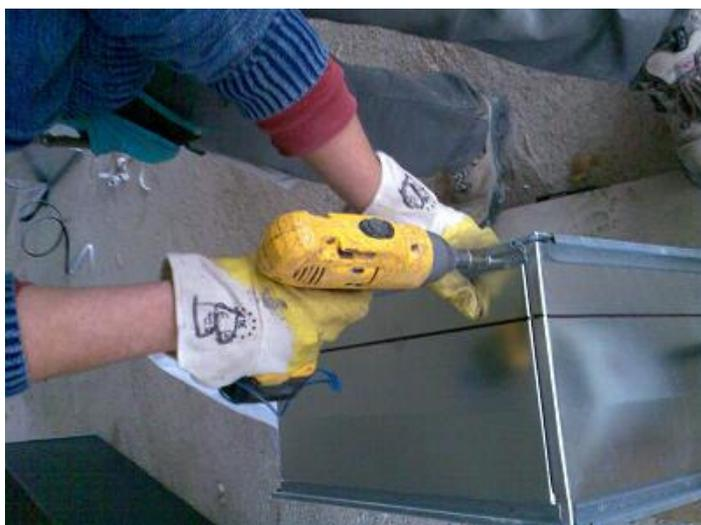
Da ultimo verrà la flangia verrà avvitata allo scatolare con l'impiego di viti autoforanti avvitate al pezzo con avvitatore a batteria.
