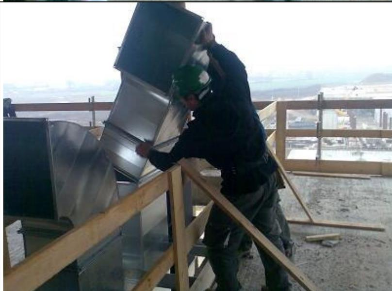
Per la realizzazione delle colonne dei montanti, Il canale viene posto in modo da far combaciare le flange di connessione. Una volta posizionato, un operatore mantiene in posizione il pezzo ed il secondo operatore posizione all'interno degli appositi alloggiamenti le viti di connessione e provvederà al loro serraggio.
