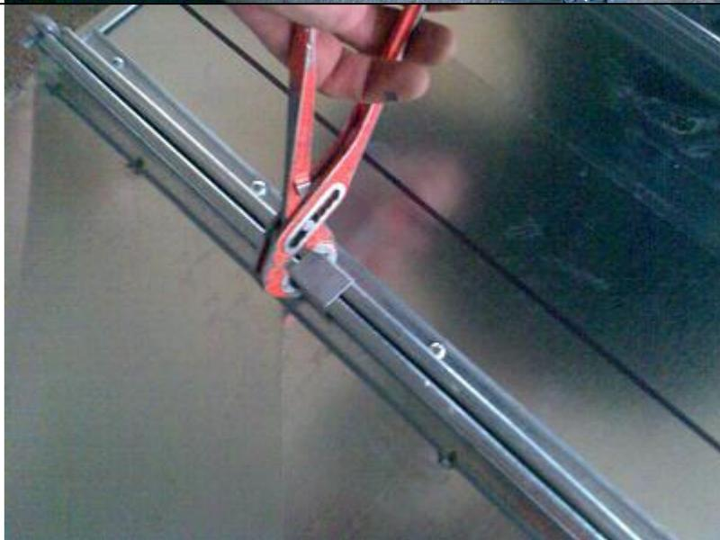
Da ultimo verrà applicata una clips al fine di serrare le giunture e garantire la tenuta delle guarnizioni.
