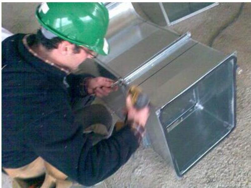
Gli elementi in lamiera vengono forniti in cantiere in blocchi presagomati standard. Possono essere isolati o non isolati secondo la loro funzione.
