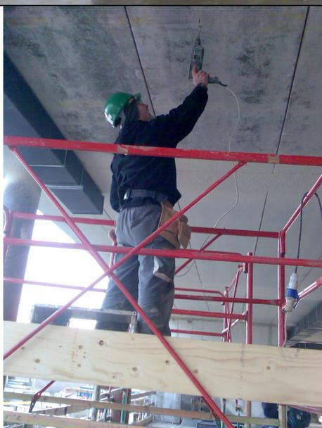
Prima di procedere al montaggio, con l'ausilio di un trabattello è necessario procedere al tracciamento a soffitto ed alla predisposizione delle sospensioni. Per tale attività necessario procedere alla foratura del solaio attraverso l'impiego di trapano.
