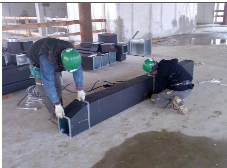
Dovendo procedere alla realizzazione delle condotte orizzontali, i canali vengono preassemblati in conci della lunghezza di 3-4 metri. I canali, vengono manovrati manualmente e assemblati con le apposite viti e le apposite clips di serraggio
