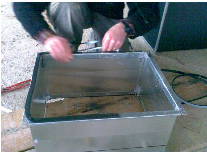
Qualora ne siano sprovvisti, sulle giunzioni verrà applicata una striscia di guarnizione. Tale operazione viene eseguita manualmente
